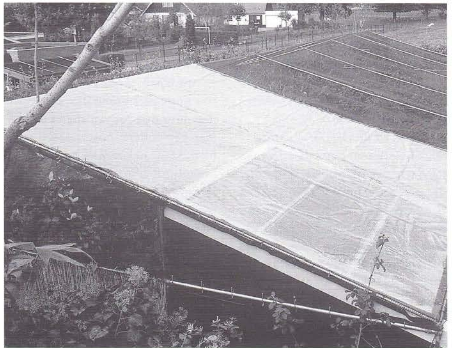
Zicht op het dak van de volière
