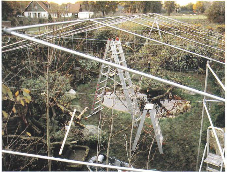
Tijdens de bouw van de volière
