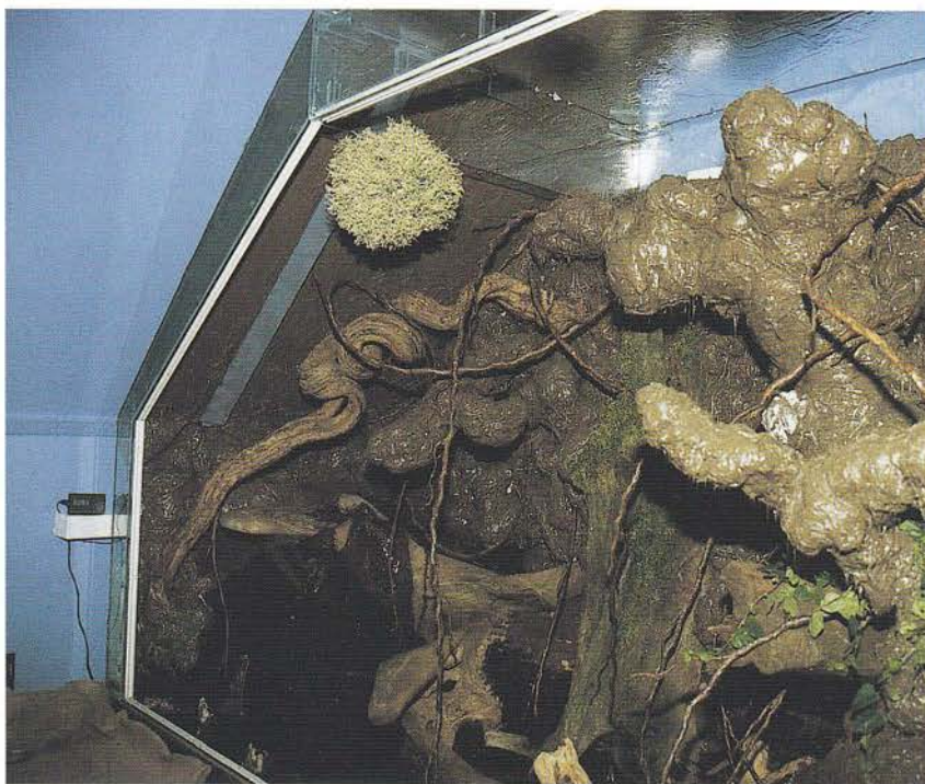
Het terrarium in aanbouw. Foto: Erik Wevers
